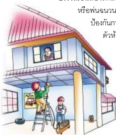
พ่นฉนวนที่ฝ้าเพดาน บริเวณที่จอดรถ
